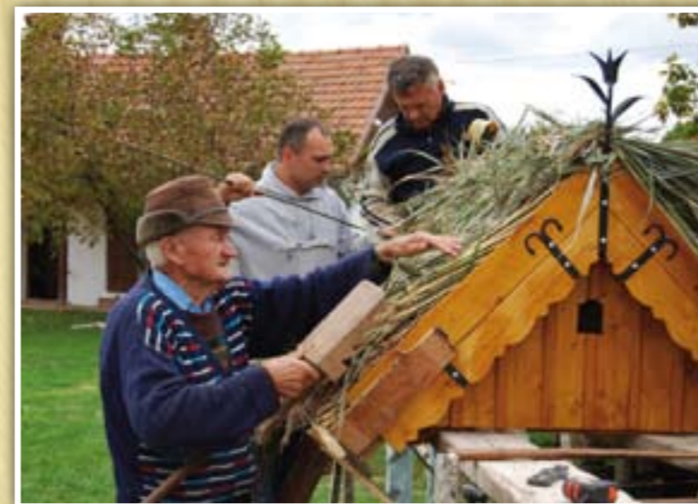
A szeghalmi Zsila József és segítői a nádtető készítésének munkafázisai közben. Varrás, a nád elgazítása nádverővel – Csökmő, 2006
