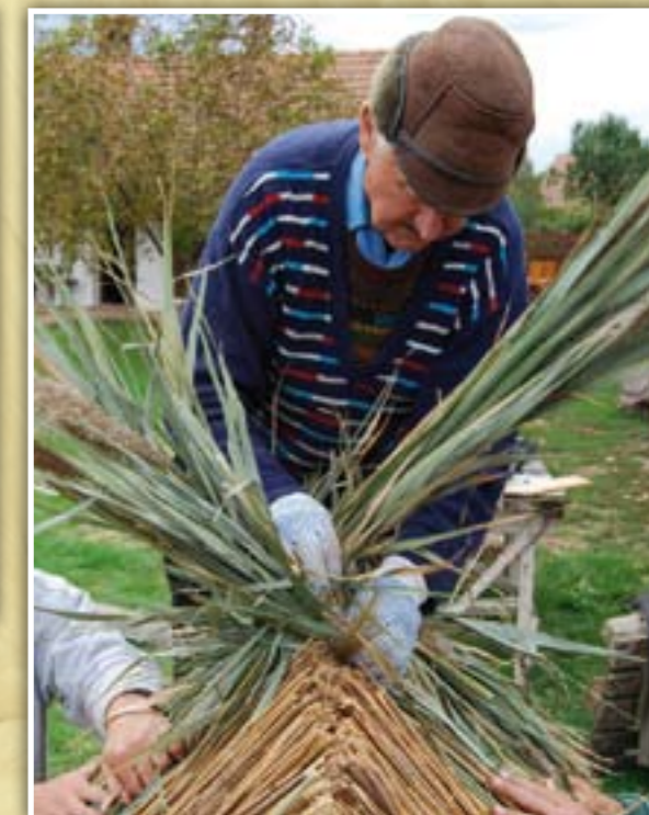
A tető gerincének kötése – Csökmő, 2006
