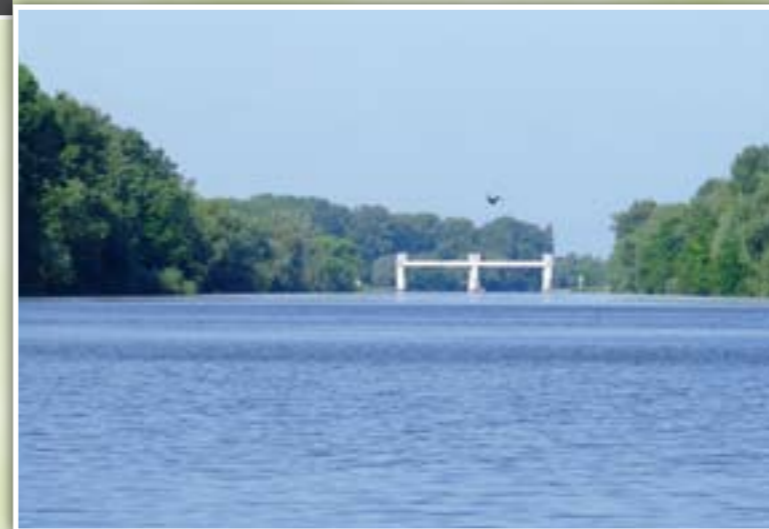
A békésszentandrási duzzasztó a felváz felől
