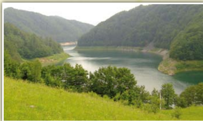
Víztározó a Jád-völgyében
