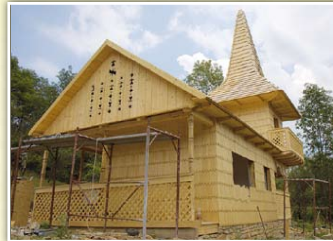
Mihálcz Elek által épített nyárilak felújítás közben
